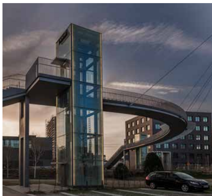
Abb.: Die Schrägseilbrücke wurde in integraler Bauweise realisiert. Im Bereich der Gleisanlage erreicht die Spannweite eine Länge von 77 m bei über 9 m Höhe.
