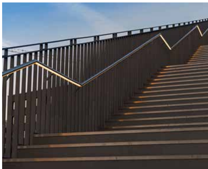
Abb.: Um keinerlei sichtbare Unterbrechung der Lichtlinien zu erreichen, neigte man das Edelstahl-Nutrohr um 20° in Richtung der Verkehrswege und verband es mittels seitlich angeschweißter Spezialhalterungen mit dem Geländer.
