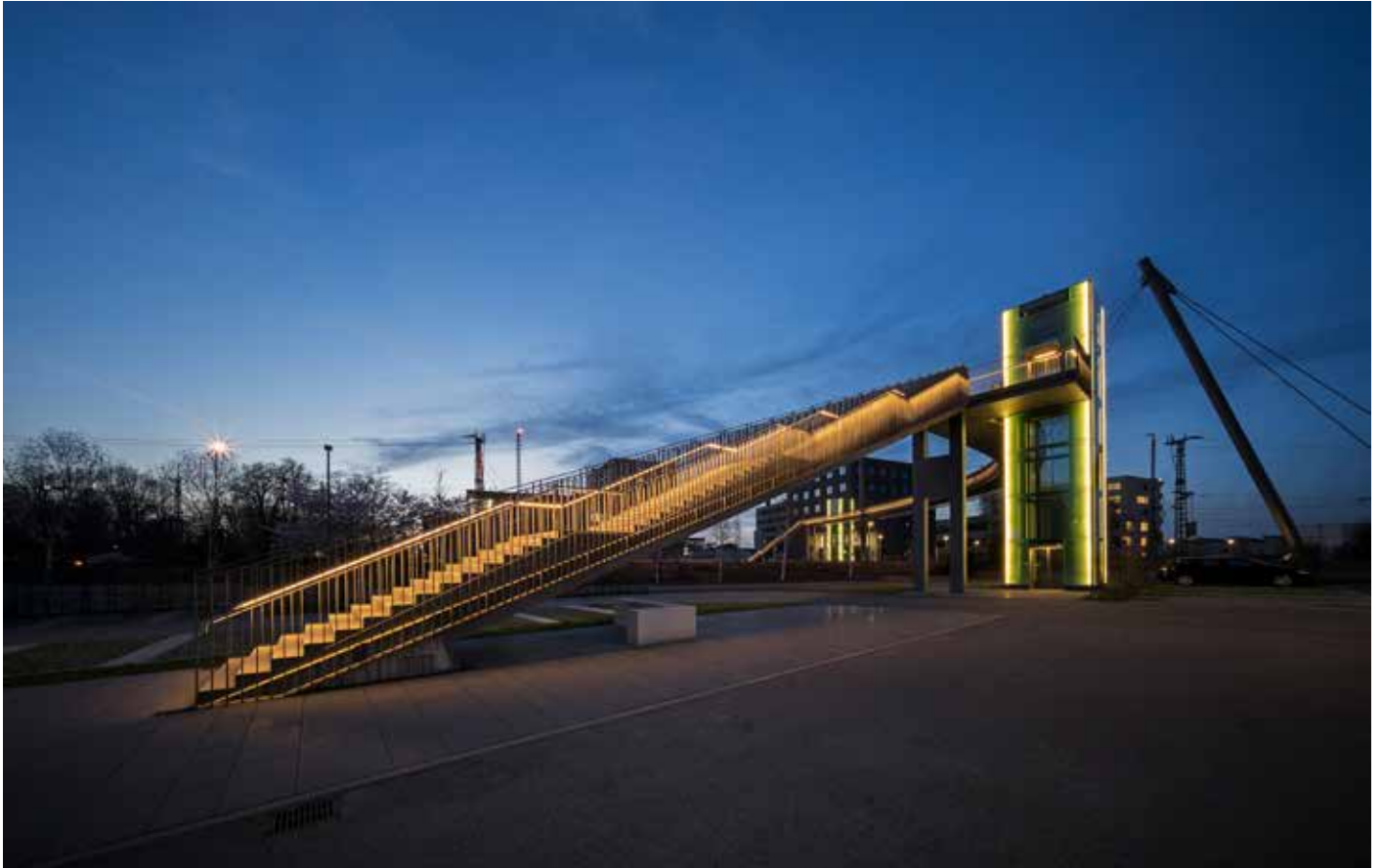
Abb.: Bei Dämmerung startet die Beleuchtung mit 100 % Lichtleistung, um bei zunehmender Dunkelheit langsam herunterzudimmen. Nachts wird nur noch das notwendige Mindestbeleuchtungsniveau gehalten.
