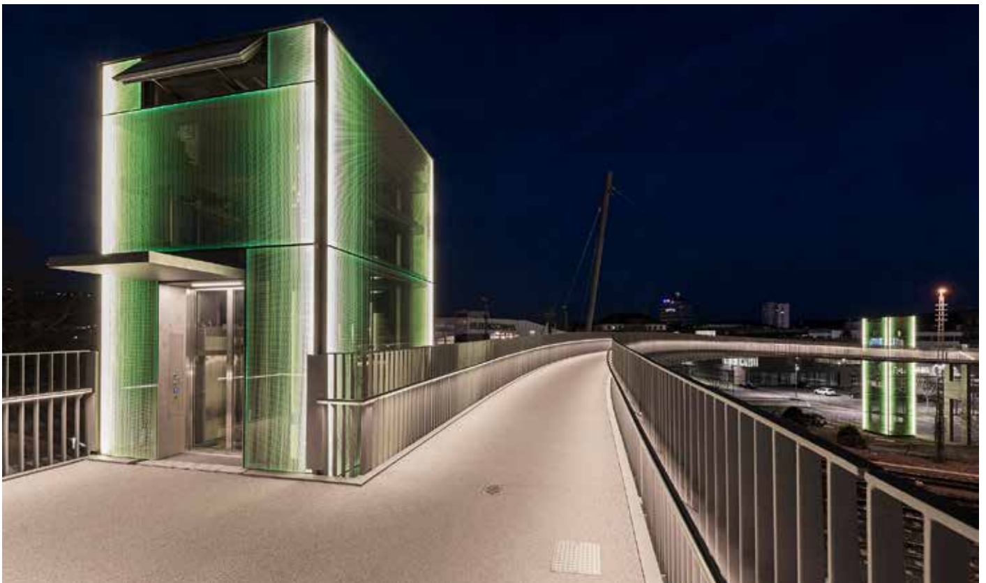
Abb.: Auf Basis des »kor#01-Optik LEDsystems« entwickelte man eine Spezial-Umlenkoptik, welche die benötigte Lichtmenge in dem nur 8 mm breiten Spalt in die Verbundglasscheiben einkoppelt.
